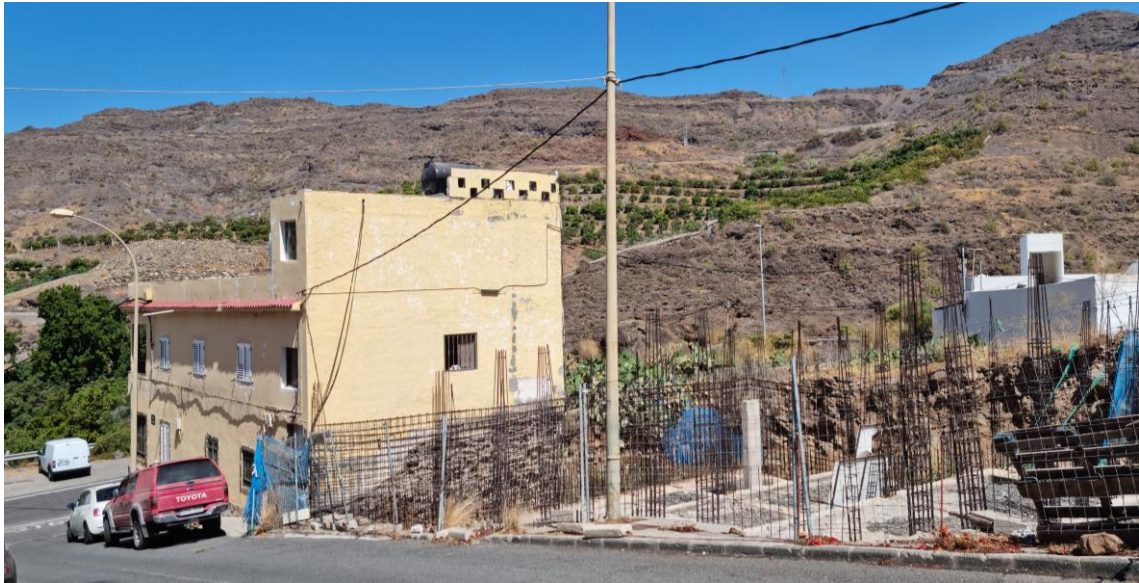
Medianera no integra y edificación inacabada próximas al acceso sur del núcleo de La Vistilla. Fuente: LPA Studio.
