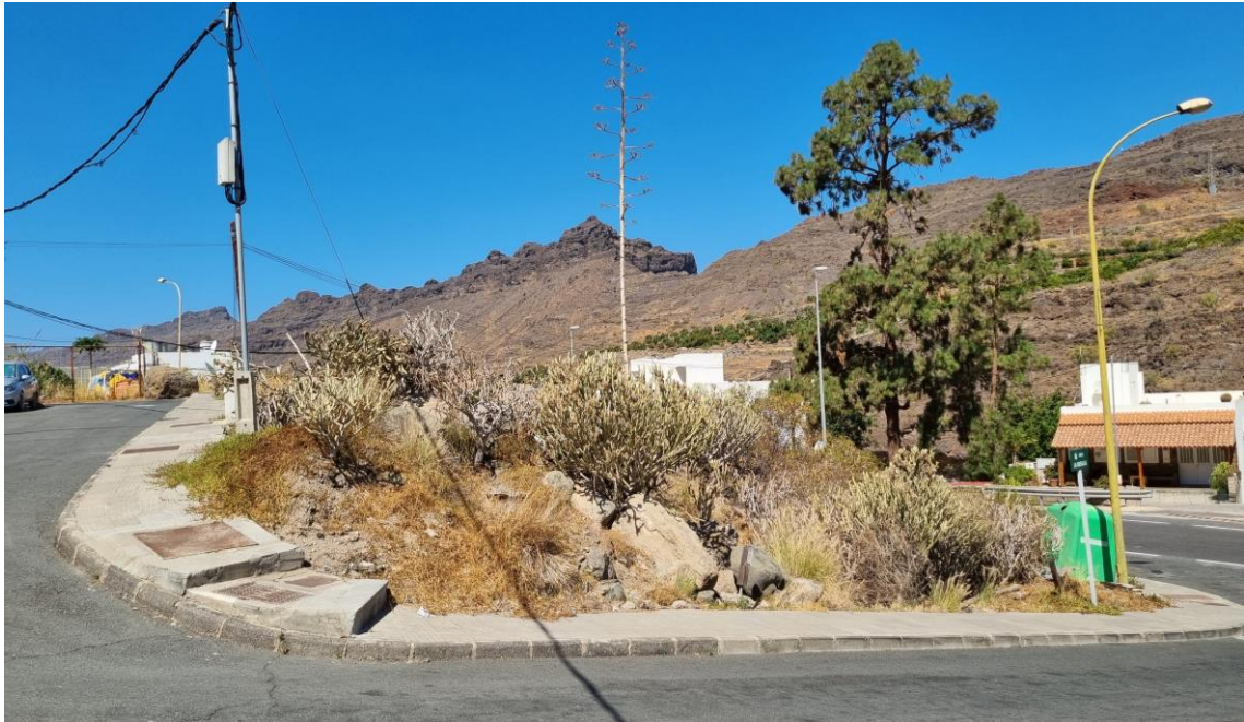
Escalones inclinados con huella y contrahuella de diferente altura; Ausencia de rampas. Fuente: LPA Studio.
