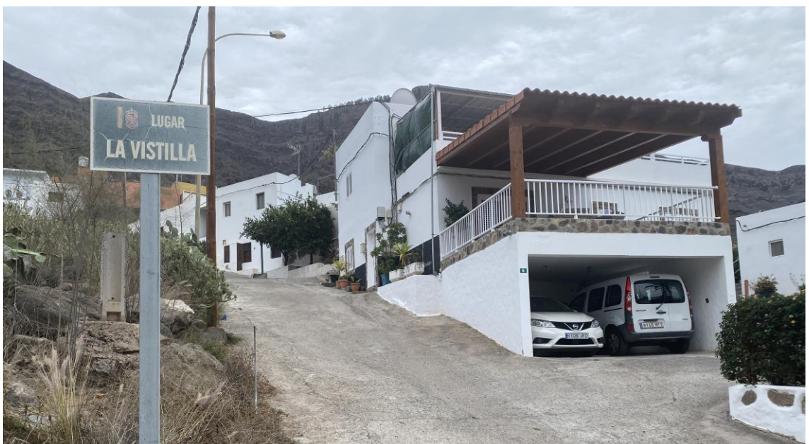
Entrada al rodonal sur desde la GC-200 (margen derecho en dirección norte). Fuente: LPA Studio.
